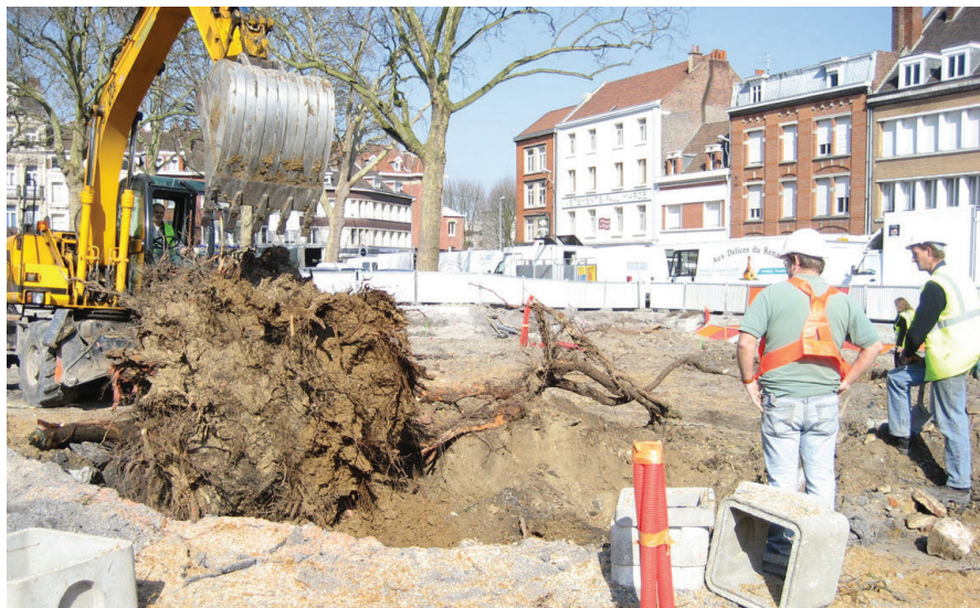
Building development works © Communauté d'agglomération du Douaisis - Direction de l'archéologie préventive
